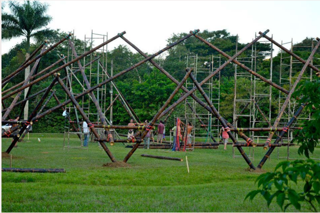
Figura 9 – Montagem da Oca dos Saberes
