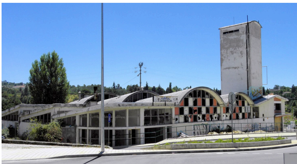
Fig. 7 - Panificadora em Vila Real, de Nadir Afonso, actualmente abandonada, degradada e vandalizada, 2010.
