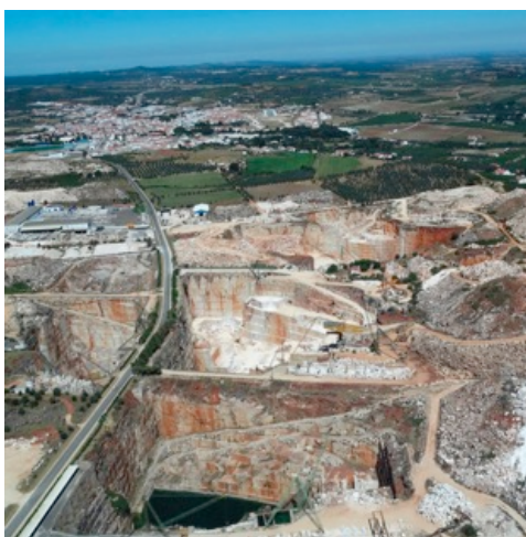
Fig. 3 - Vista aérea da estrada entre Borba e Vila Viçosa 12
