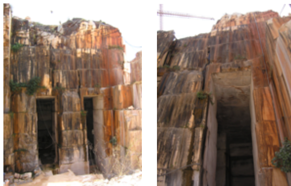
Fig. 17 - Imagem de dois dos acessos da zona aberta da pedreira referida nas imagens anteriores para zona de galerias subterrâneas de extração. Imagem de Susana Piteira (realizada a 26 de Junho de 2016).
