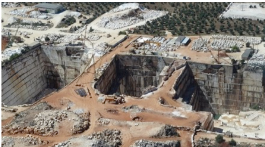
Fig. 7 – Vista aérea de várias de cavidades de pedreiras 15 .
