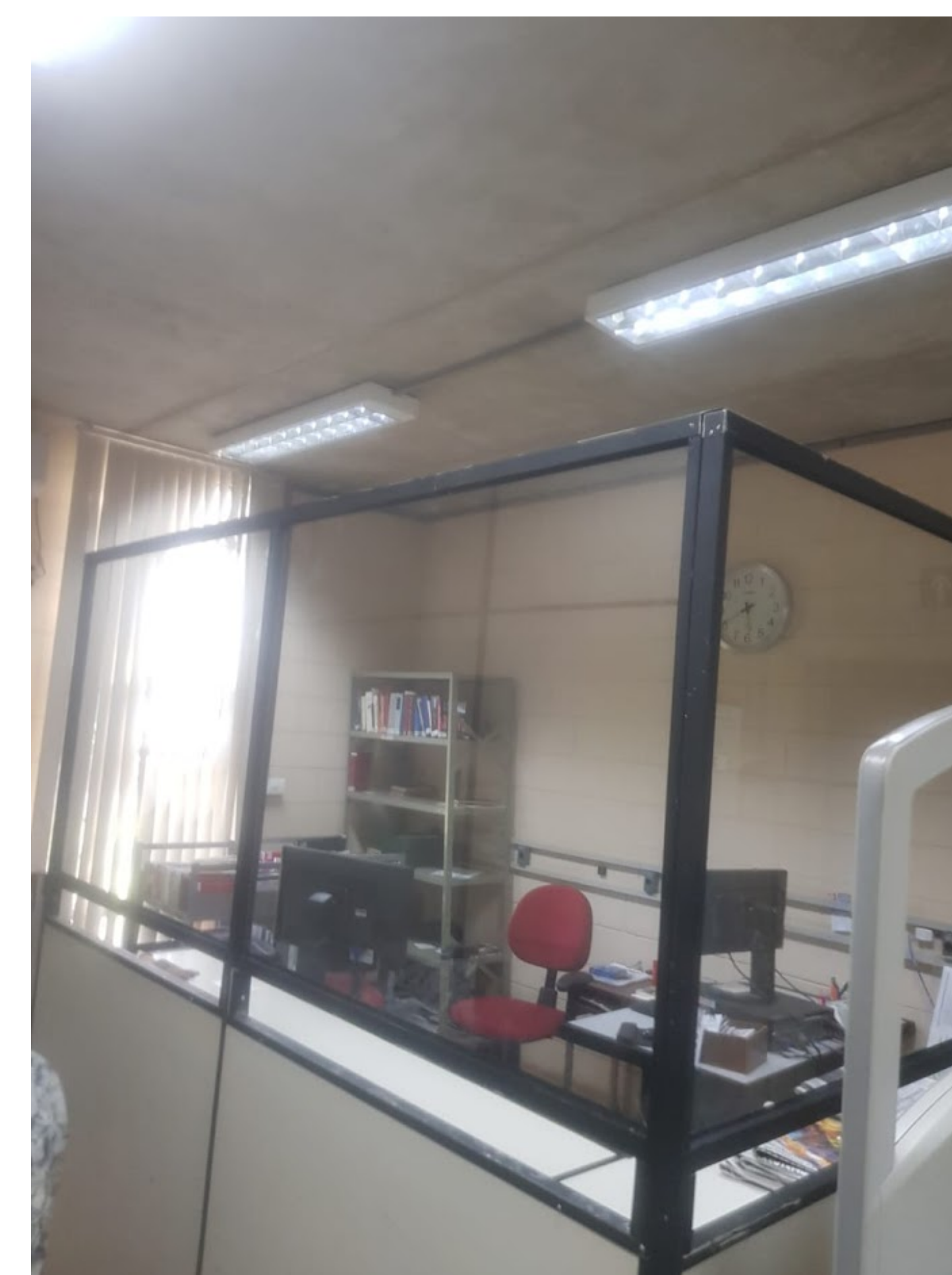
Legenda: Colocação de proteção de vidro no Balcão de Atendimento ao Público da Biblioteca-IEL em 06 de julho de 2020
