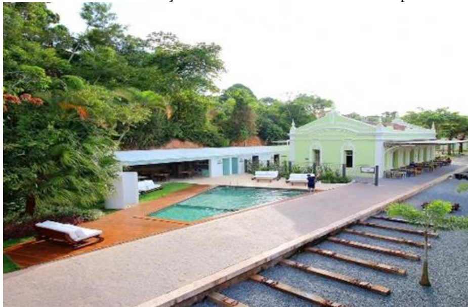
FIGURA 07 - Estação Bananeiras Pousada Antes – Depois
