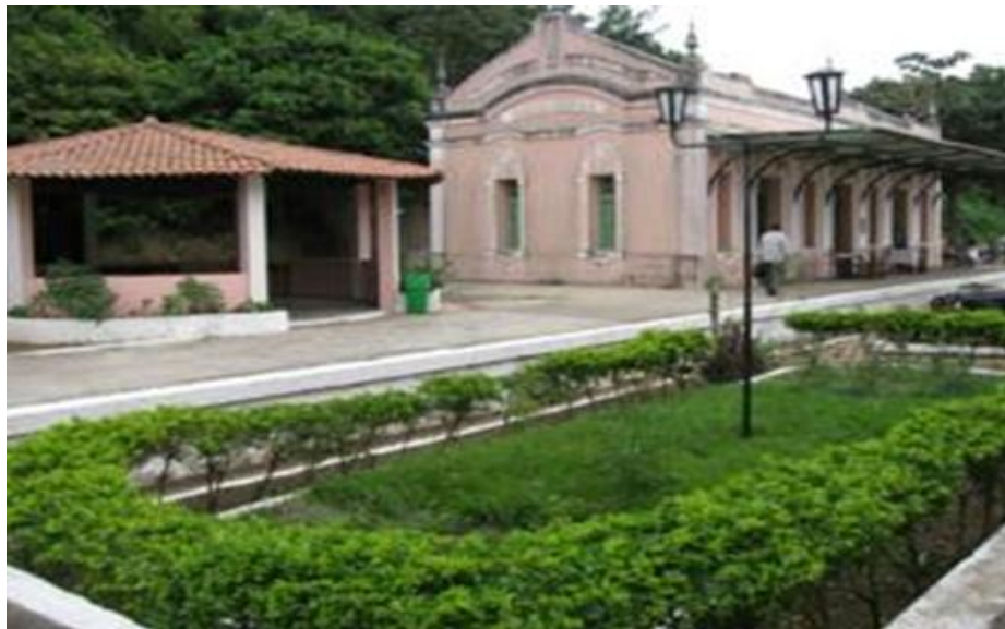
FIGURA 06 - Estação Bananeiras Pousada – Antes
