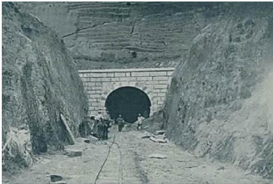
FIGURA 02 - Túnel sob a Serra da Viração, 1922.
