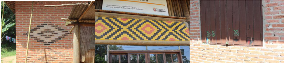
Imagens 25, 26 e 27 – Esquerda (img. 25): padrão construído com os módulos do tijolo, aldeia Tenonde Porã. Meio (img. 26): variação do padrão da jararaca, aldeia Tenonde Porã. Direita (img. 27): aplicação em janela do padrão de bifurcação. Aldeia Tenonde Porã. (A autora, 2016).
