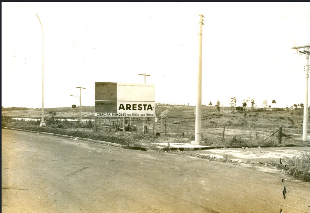
Fotografia 4 – Terreno destinado para a construção do IFCH, 1971 (Acervo do SIARQ-Unicamp).
