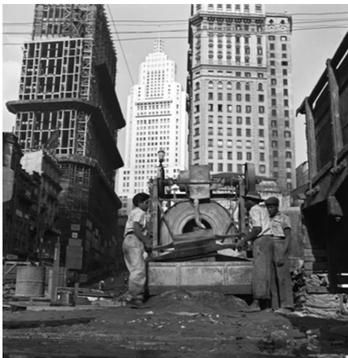
4. Alice Brill, Prédio em construção no Vale do Anhangabaú: vista do Edifício Martinelli e Banco do Brasil, c.1950, Acervo Instituto Moreira Salles
