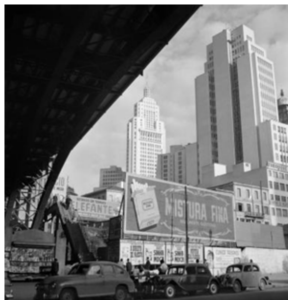
5. Alice Brill, Estrutura do Viaduto Santa Ifigênia e prédio do Banco do Estado de São Paulo, Centro, s/d, Acervo Instituto Moreira Salles
