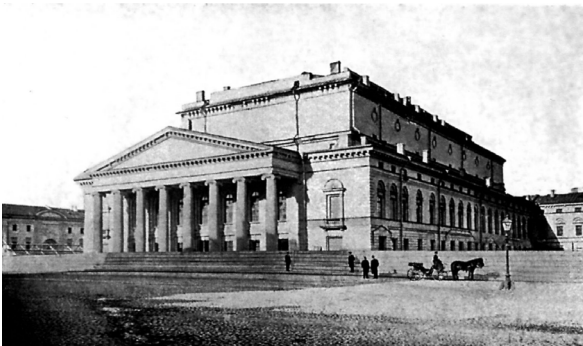
Fig. 1 – Teatro Bolshoi Kamenny, 1886 (demolido) – São Petesburgo.
