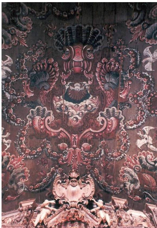
FIG. 1 – Forro da capela-mor da igreja de Santa Quitéria Gonçalo Francisco Xavier, Catas Altas (MG). Tarja central “solta”. Foto do arquivo do IEPHA/MG
