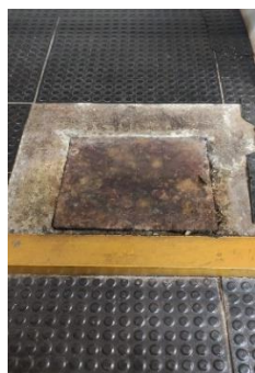
1 - Antes da demarcação para esgoto.
