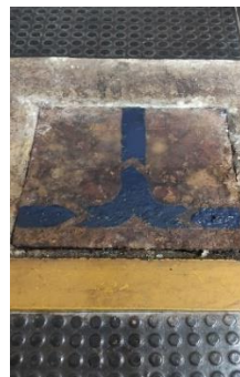
2 - Após demarcação da tampa do esgoto, sentido de via de canalização.
