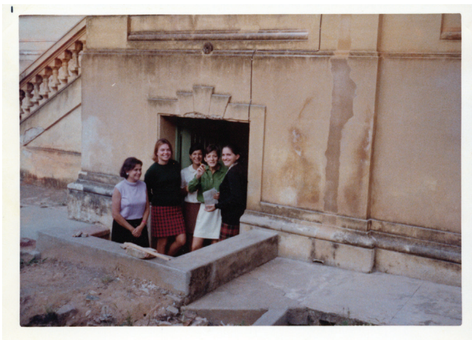
Figura 6: Imagem do subsolo da sede inicial da Unicamp em junho de 1969. À esquerda, destaque para as duas técnicas do CBPF.
